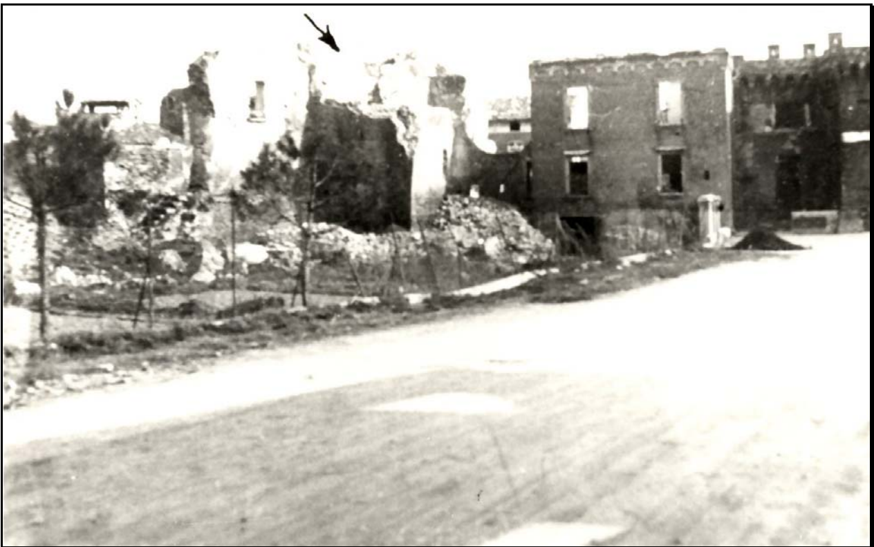
RESTI DELLA TORRE DELLA ROCCA
