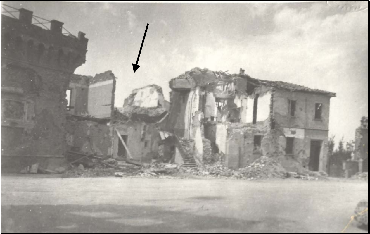
PIAZZA GARIBALDI (Torre Distrutta)
